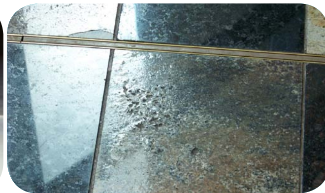
spalling
